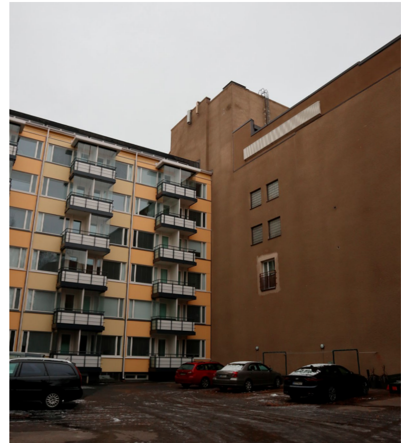
Teatterin ja asuinkerrostalon liittymäkohta.
