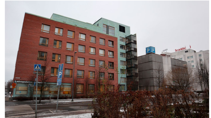
Suvantopuiston sisäänkäynti ja rakennukset Tiiliruukinkadulta.
