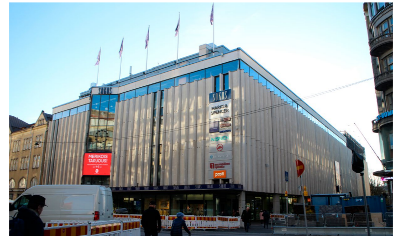
Sokoksen liikerakennus Kuninkaankadun ja Hämeenpuiston kulmauksessa.
